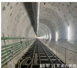
池町川第二放水路（仮称）
