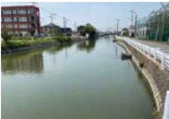
排水前の掘割
