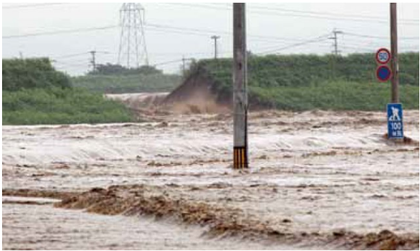
平成24年7月14日 午後1時20分頃 矢部川右岸六合の津留橋上流の堤防が決壊
