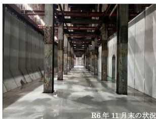
池町川地下調整池（けやき通り）
