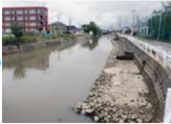
先行排水によって 水位が下がった掘割
