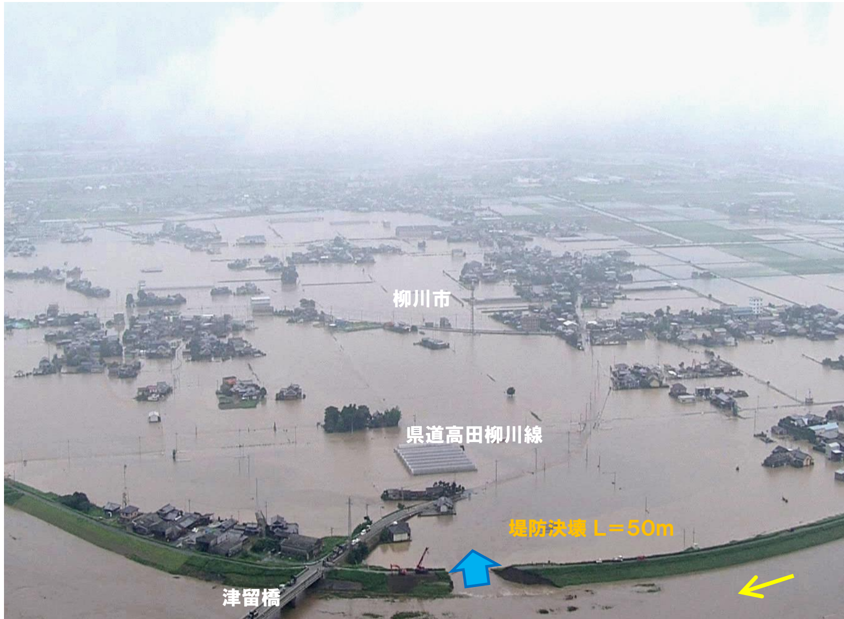
矢部川堤防決壊状況(右岸7.3k付近)（平成24年7月14日）
