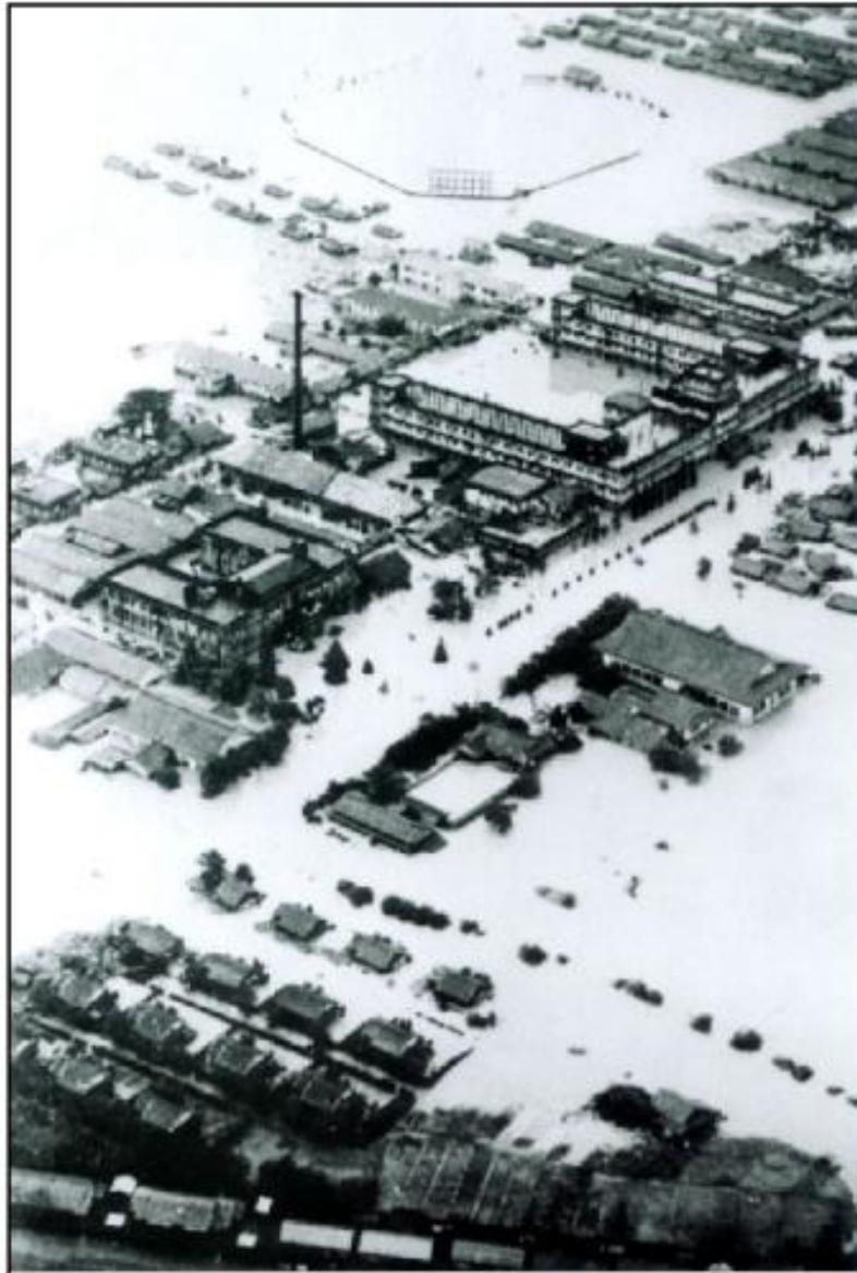
久留米市街部の浸水状況
